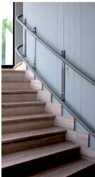
Fijación a la pared o muro
