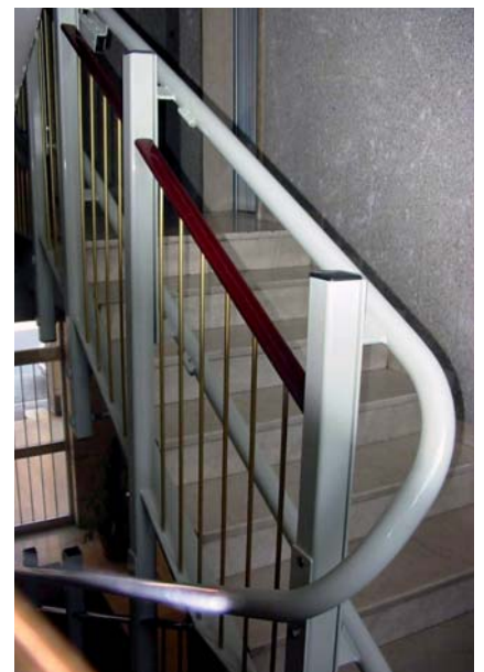
Fijación en el hueco de la escalera
